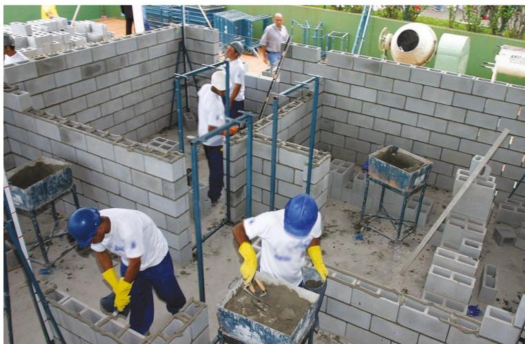
Figura 16 – Alvenaria estrutural (Fonte: LREC)
