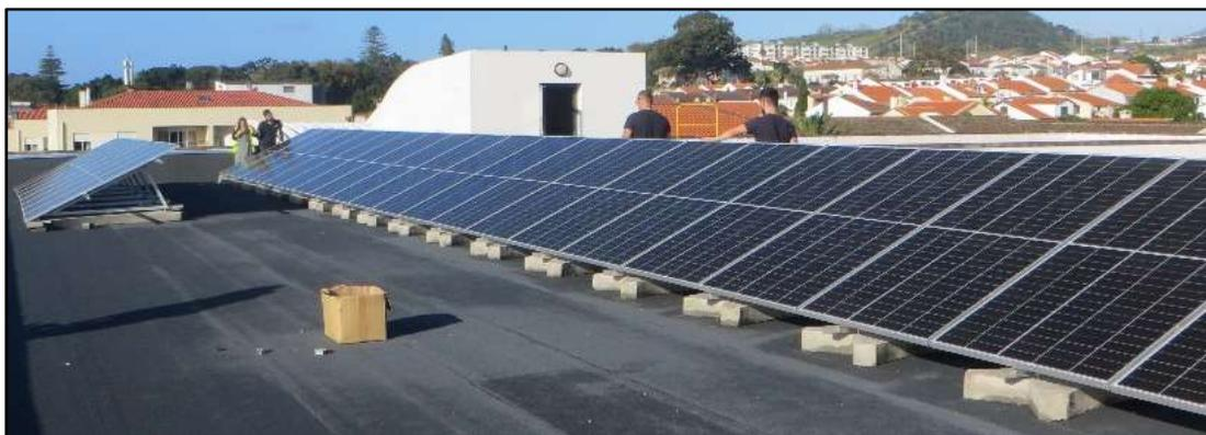
Figura 4 –Registo fotográfico dos painéis fotovoltaicos para autoconsumo montados na cobertura do LREC.
