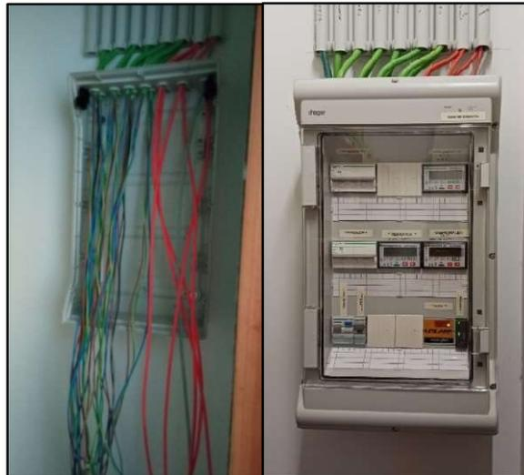
Figura 3 – Registos fotográficos a exemplificar a montagem de analisadores de energia no âmbito do SMGE do LREC.
