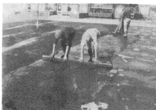
FOTO 1 - Vasamento do slurry. FOTO 2 - Regularização da superfície.
