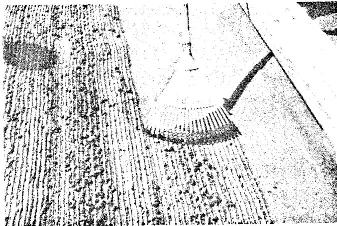
Fig.1 - Execução da estriagem
