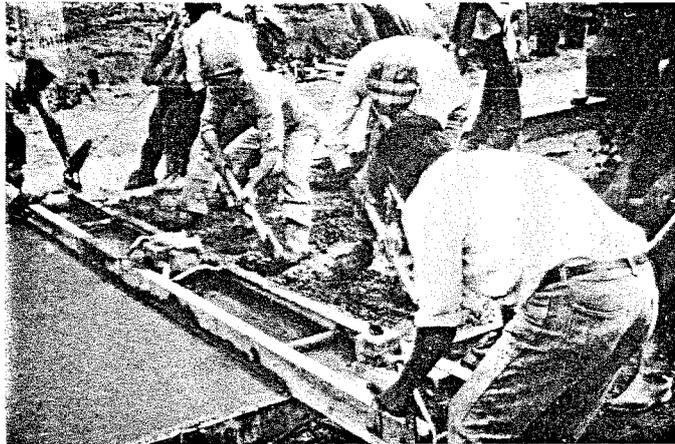
Fig.10 - Aplicação da régua vibradora
