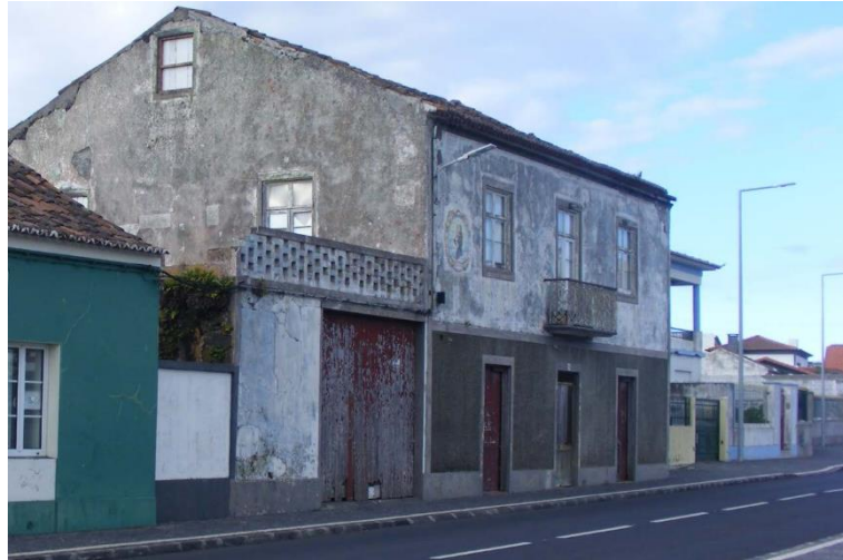
Figura 1 – Foto da fachada do edifício.
