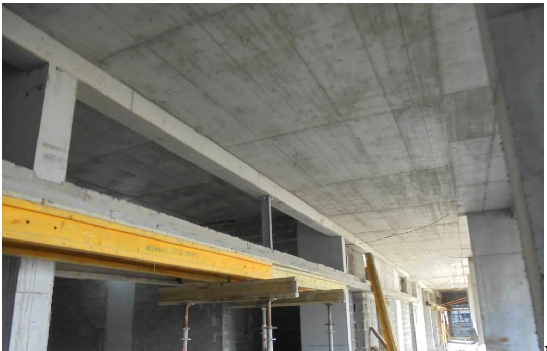
Fotografia 9 – Lintel Intermédio – Piso 0 - Bloco A
