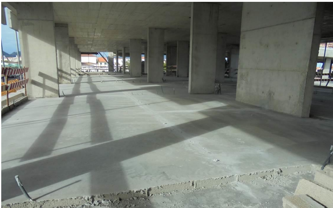
Fotografia 4 – Betonilha de Regularização – Piso 1 - Bloco A
