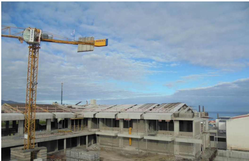
Fotografia 8 – Vista da Cobertura (Alçado Poente)
