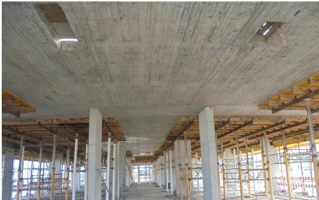
Fotografia 5 – Descofragem da Laje do Piso Técnico– Bloco B
