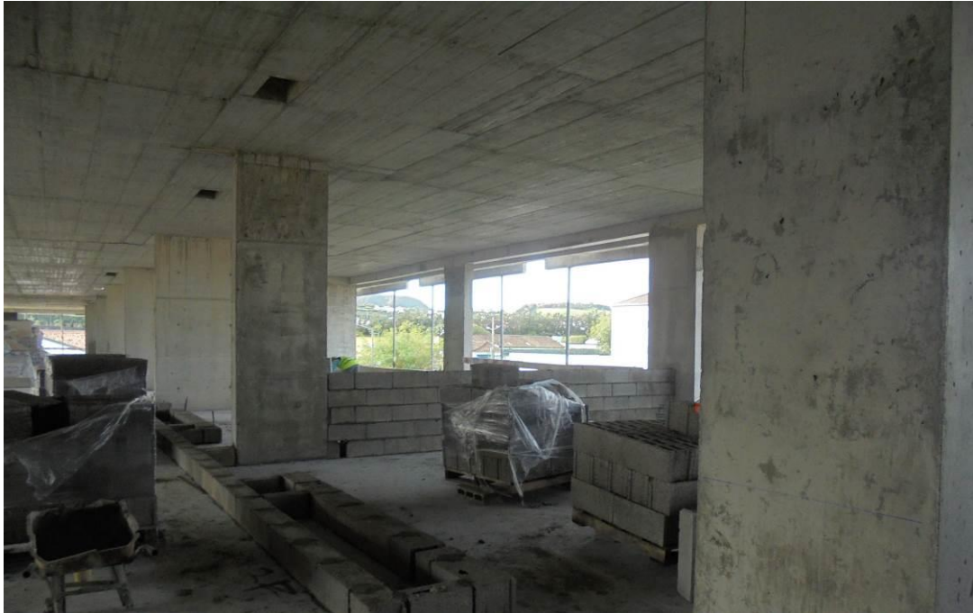
Fotografia 7 – Panos de Alvenaria Interiores do Piso 1 – Bloco A
