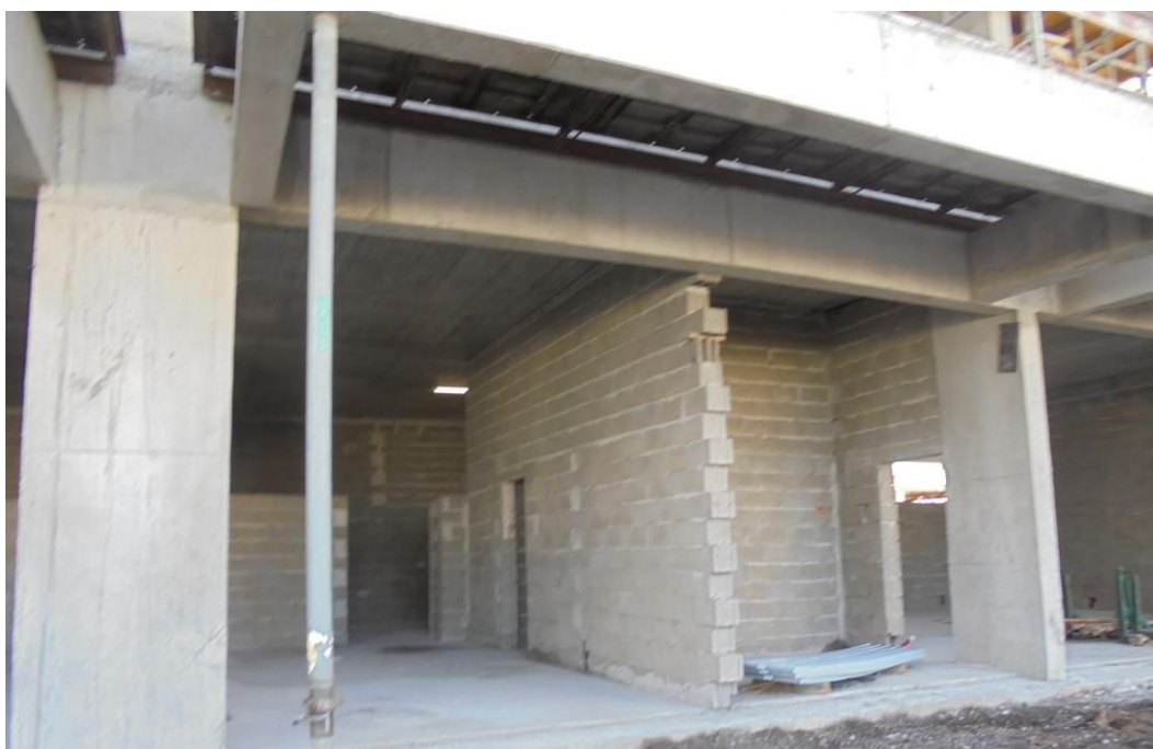
Fotografia 10 – Panos de Alvenaria Interiores do Piso 0 – Bloco B
