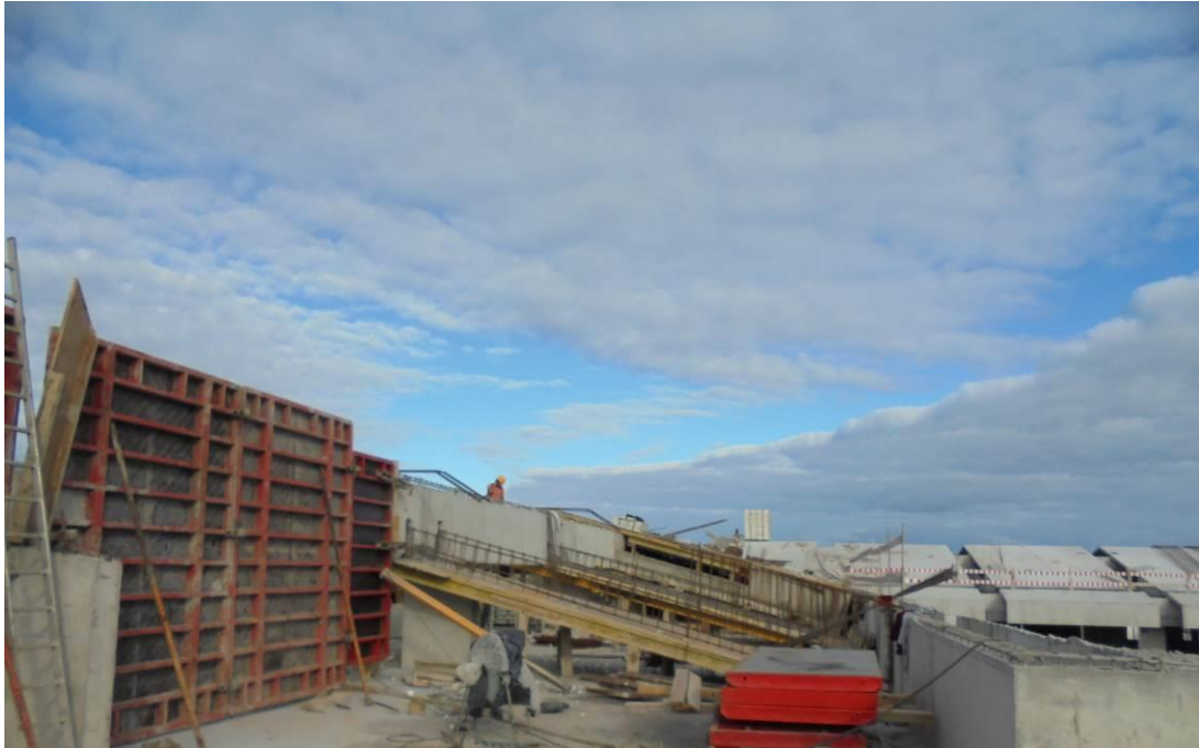
Fotografia 3 – Cofragem das Paredes da Cobertura – Bloco A
