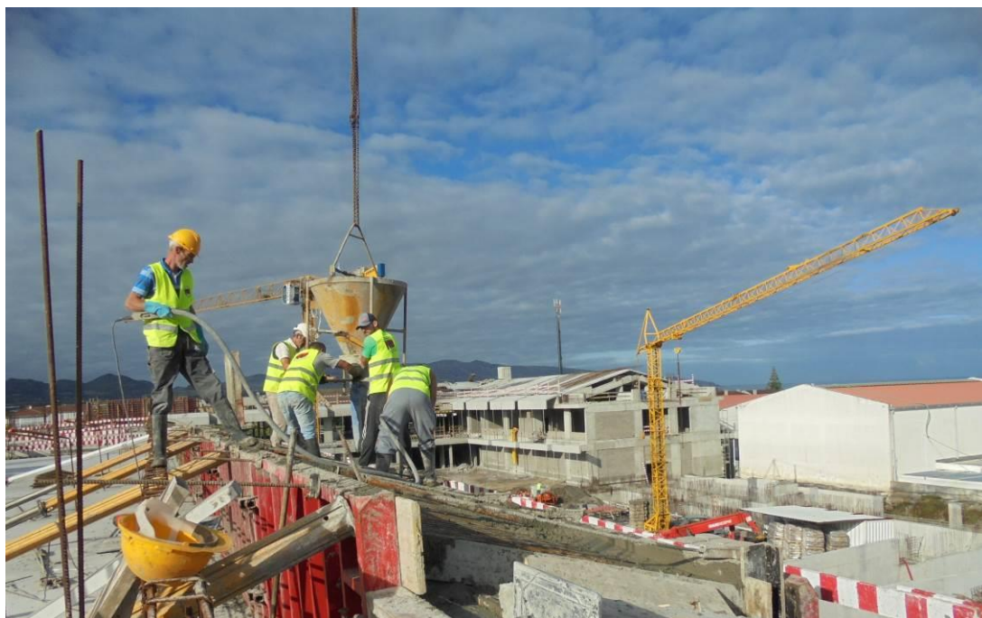
Fotografia 6 – Betonagem da Pala de Cobertura – Bloco B
