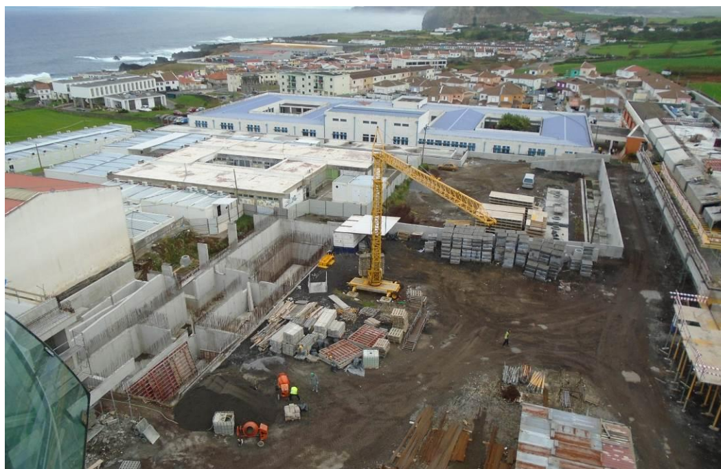
Fotografia 10 – Vista da Grua Torre (Alçado Sul)
