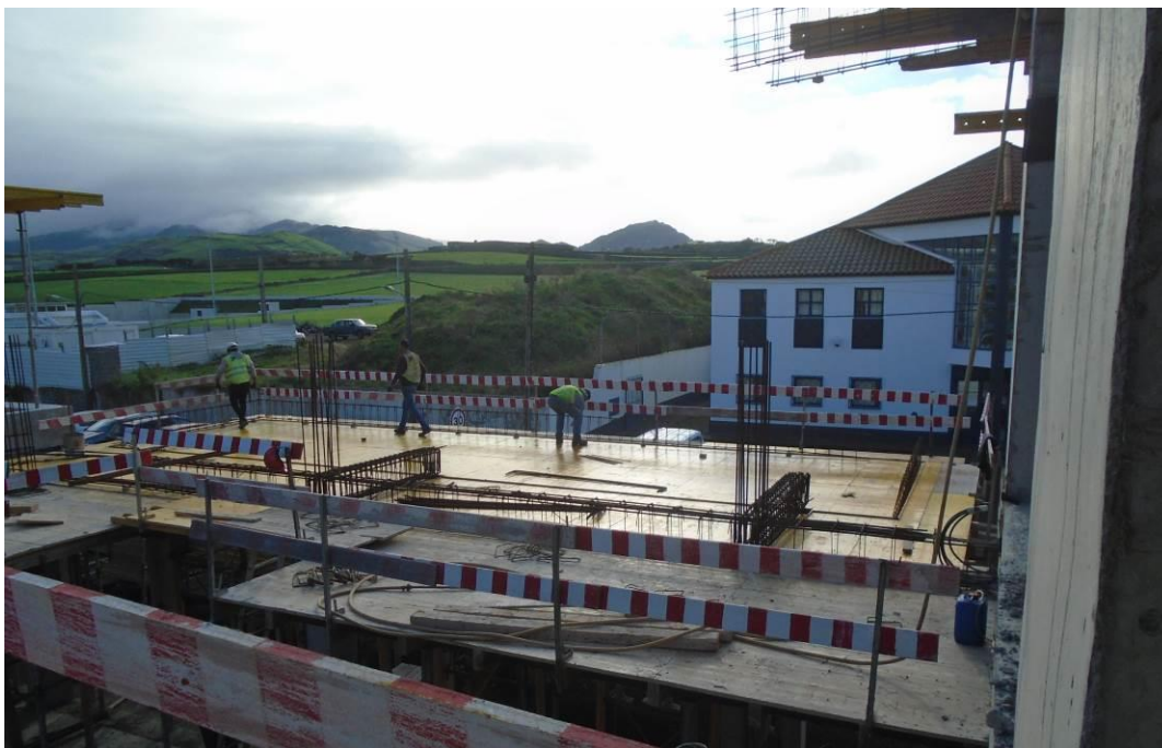
Fotografia 1 – Cofragem da Laje do Piso 1 - Bloco B
