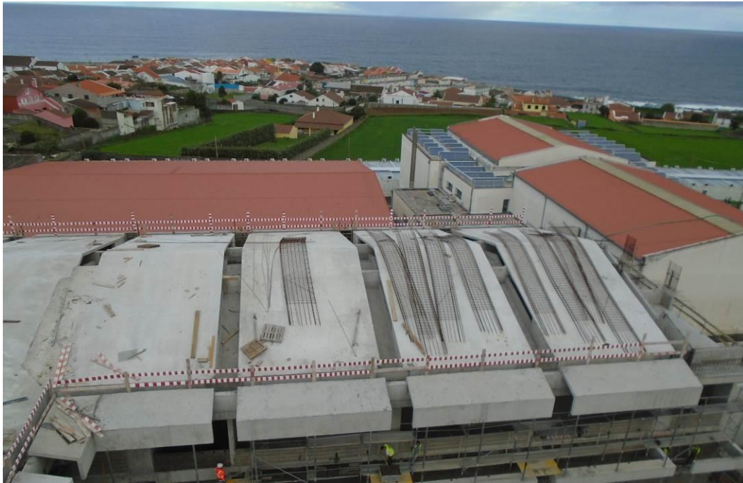
Fotografia 7 – Vista da Grua Torre (Alçado Norte)
