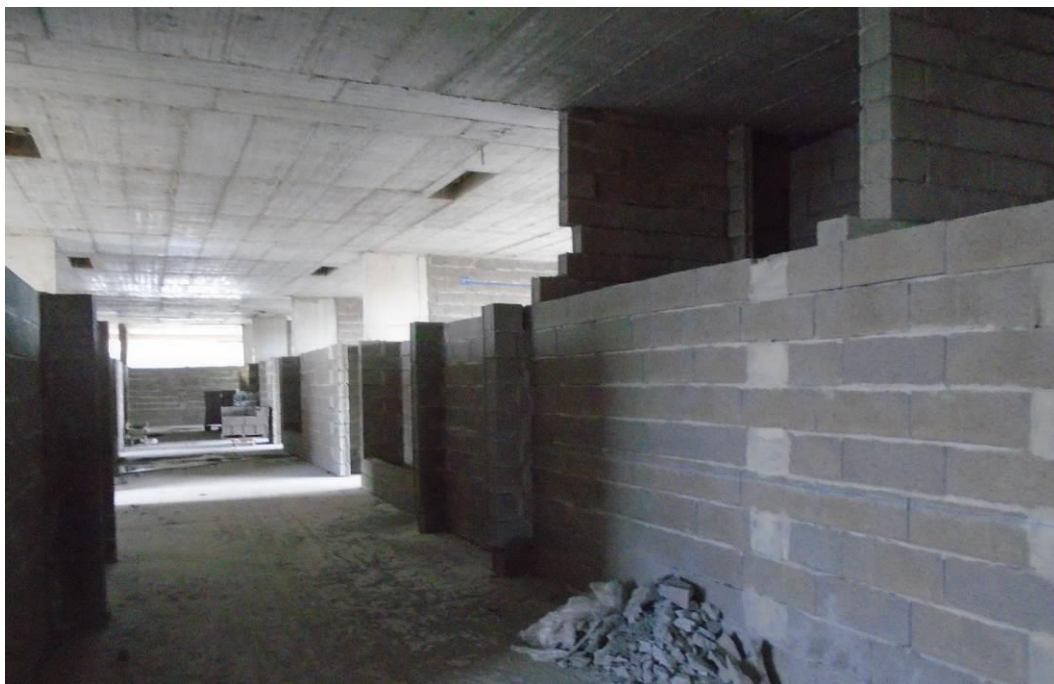
Fotografia 4 – Panos de Alvenaria Interiores do Piso 1 – Bloco A
