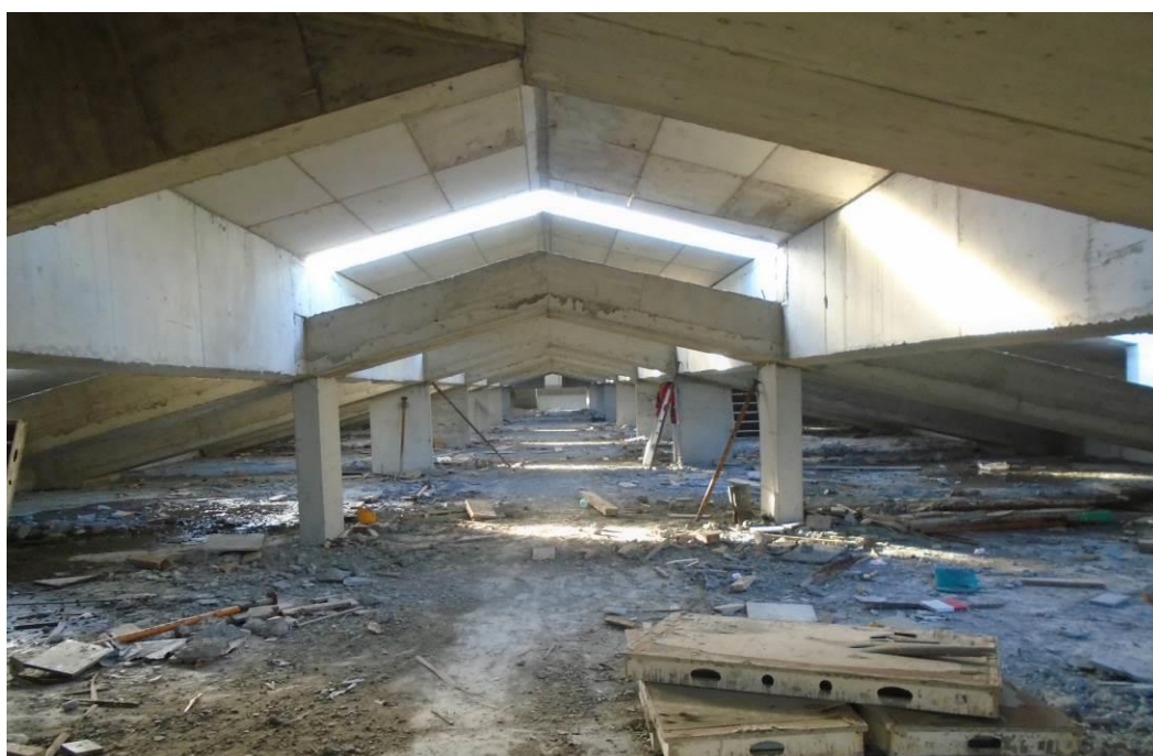
Fotografia 2 – Descofragem da Cobertura – Bloco A
