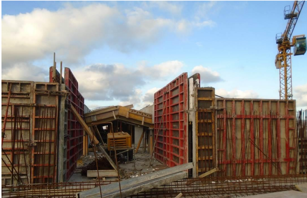
Fotografia 3 – Cofragem da Cobertura – Bloco A
