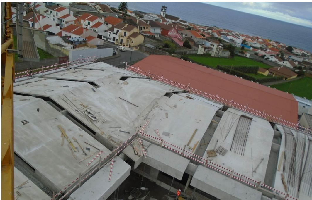
Fotografia 8 – Vista da Grua Torre (Alçado Poente)
