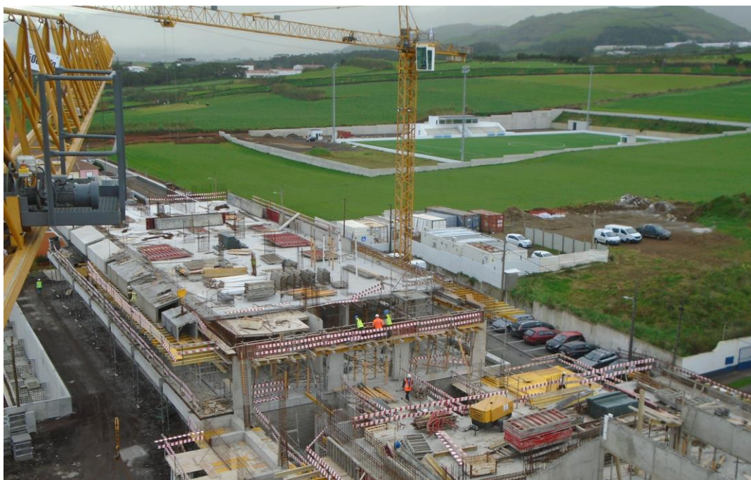
Fotografia 9 - Vista da Grua Torre (Alçado Nascente)
