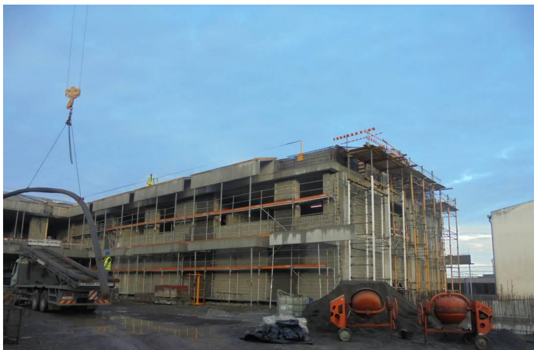
Fotografia 10 – Alvenarias Exteriores – Bloco A
