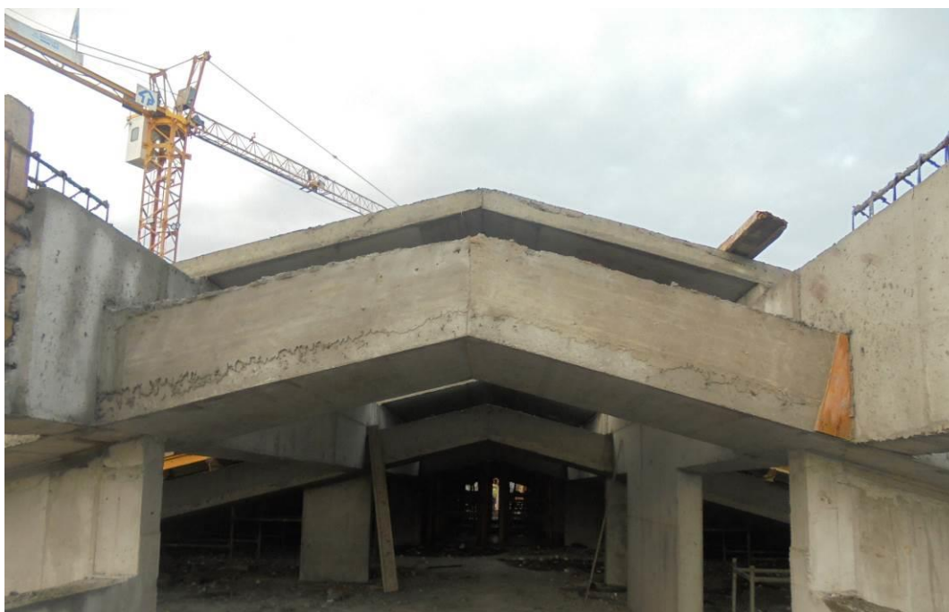
Fotografia 8 – Descofragem da Cobertura do Piso Técnico – Bloco B
