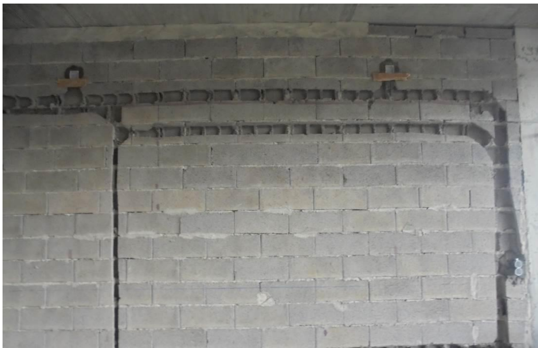
Fotografia 1 – Abertura de Roços para as Redes Técnicas - Bloco B
