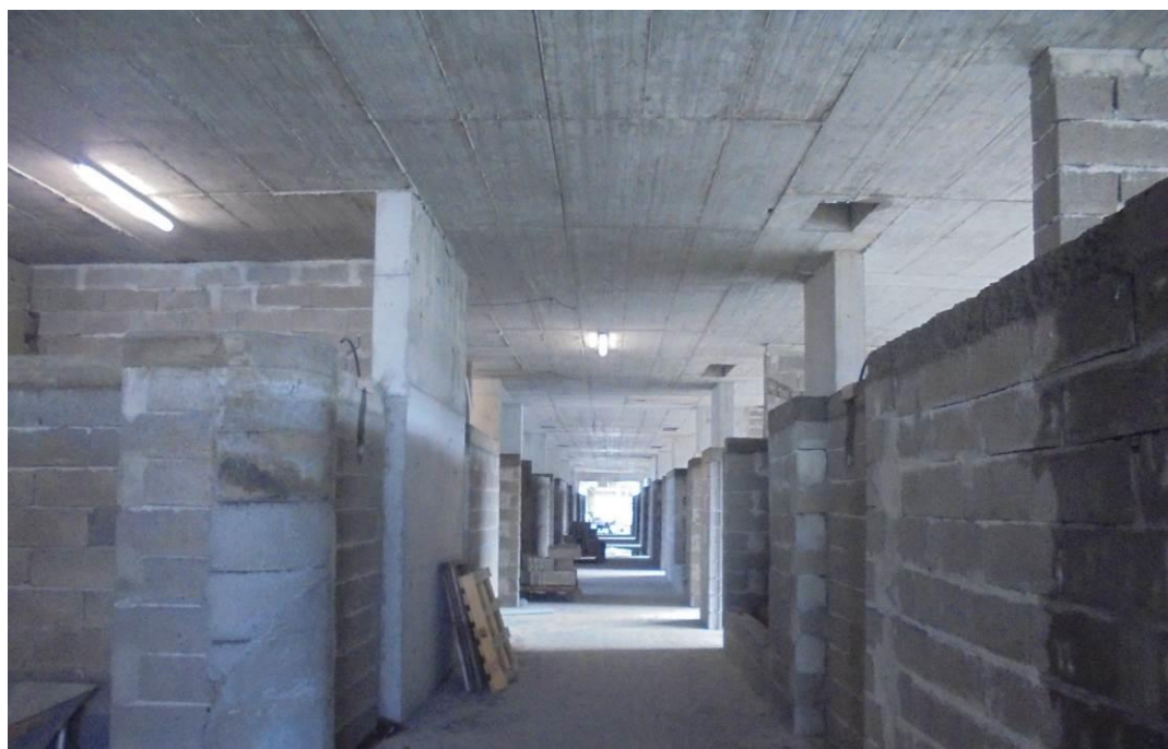
Fotografia 6 – Alvenarias Interiores - Piso 1 – Bloco B
