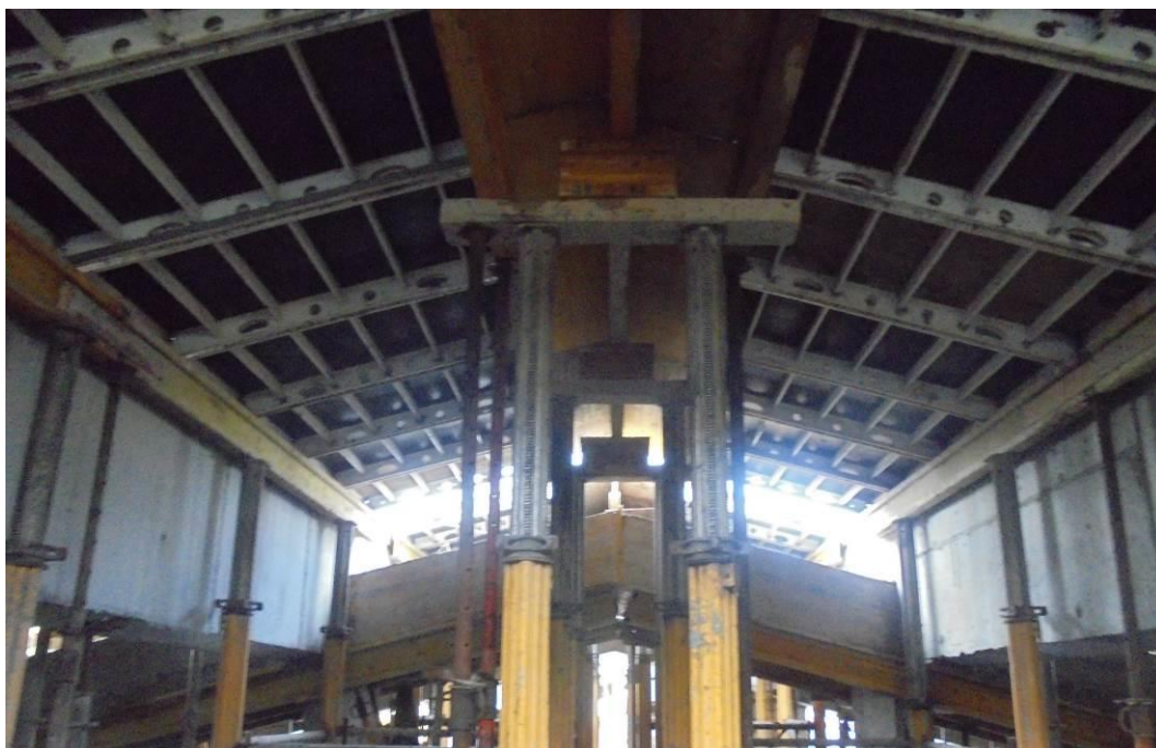
Fotografia 9 – Cofragem da Cobertura do Piso Técnico – Bloco B
