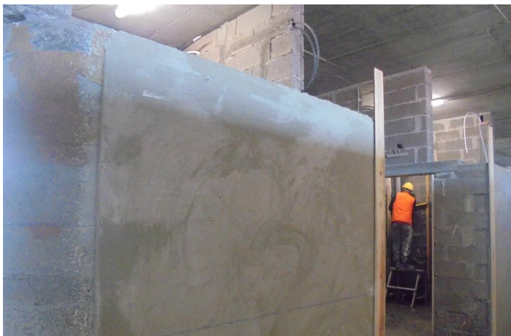
Fotografia 4 – Aplicação de Reboco em Paredes Interiores - Piso 0 Bloco A
