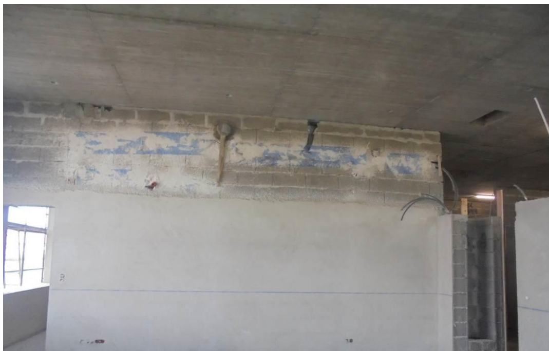
Fotografia 5 – Aplicação de Reboco em Paredes Interiores Piso 1- Bloco A
