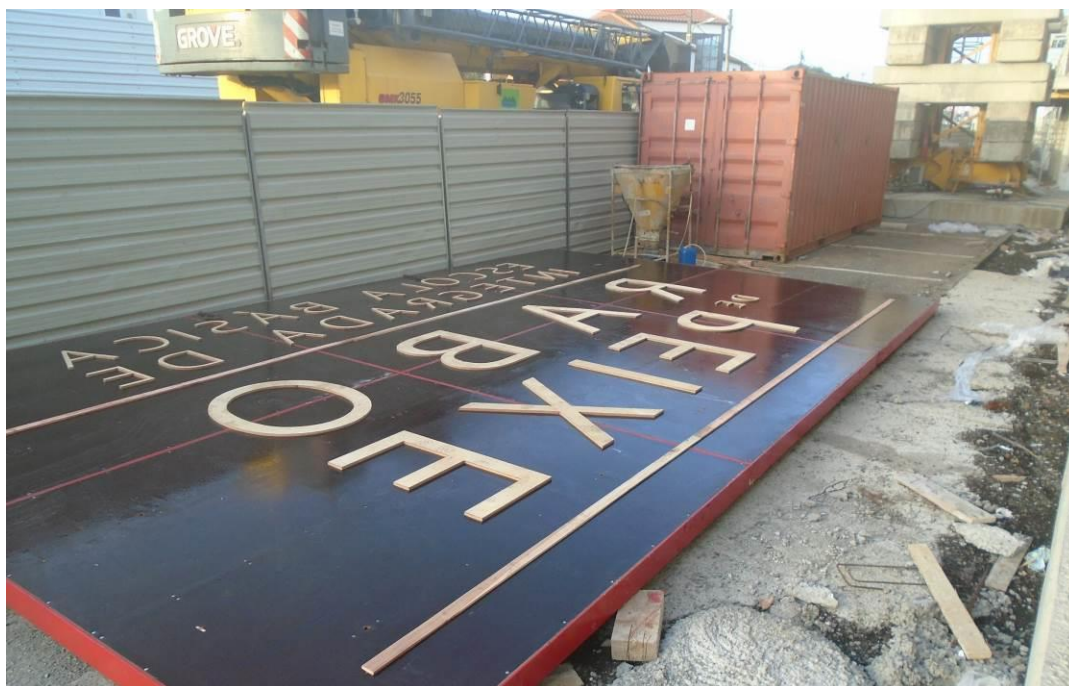
Fotografia 1 – Cofragem com negativo do “Lettering” da Escola
