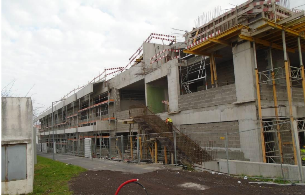
Fotografia 5 – Armaduras da Escada Exterior
