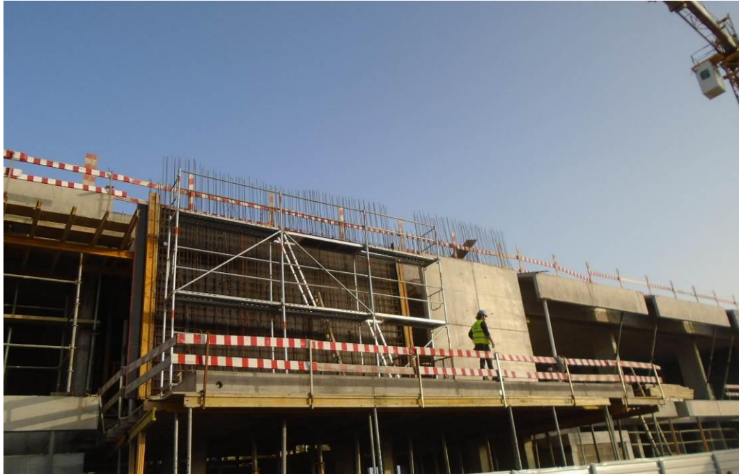
Fotografia 3 – Cofragem das Paredes das Fachada – Bloco A
