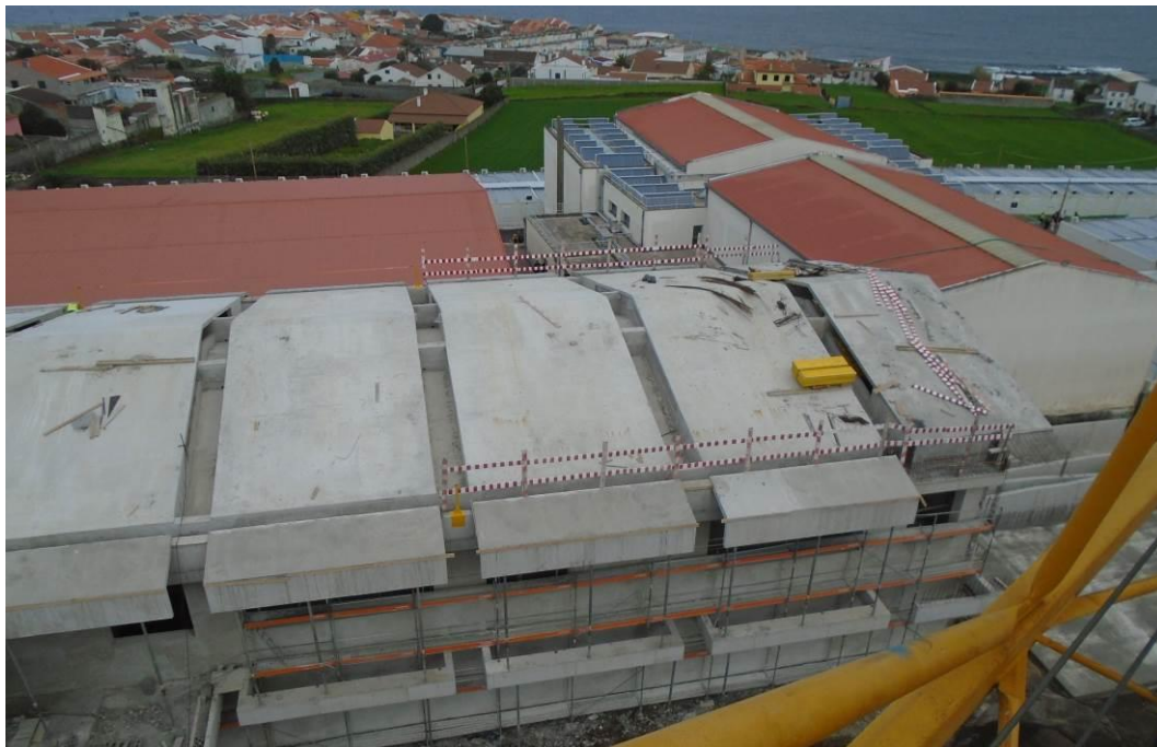
Fotografia 7 – Vista da Grua Torre (Alçado Norte)
