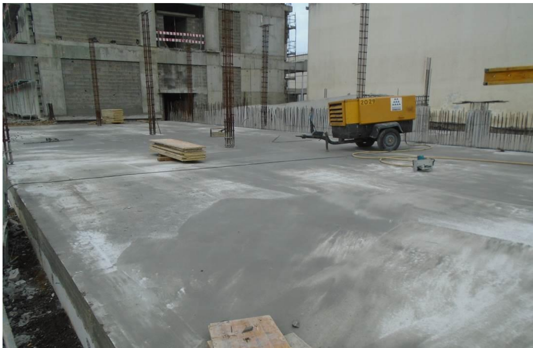
Fotografia 6 – Lajes dos Reservatórios
