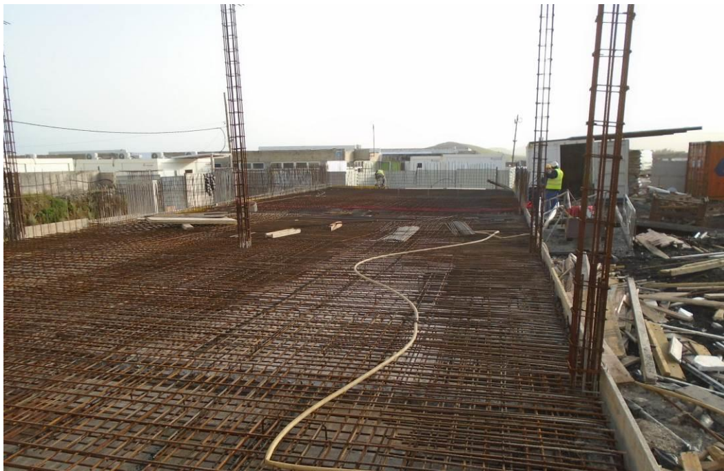
Fotografia 4 – Armaduras das Lajes dos Reservatórios
