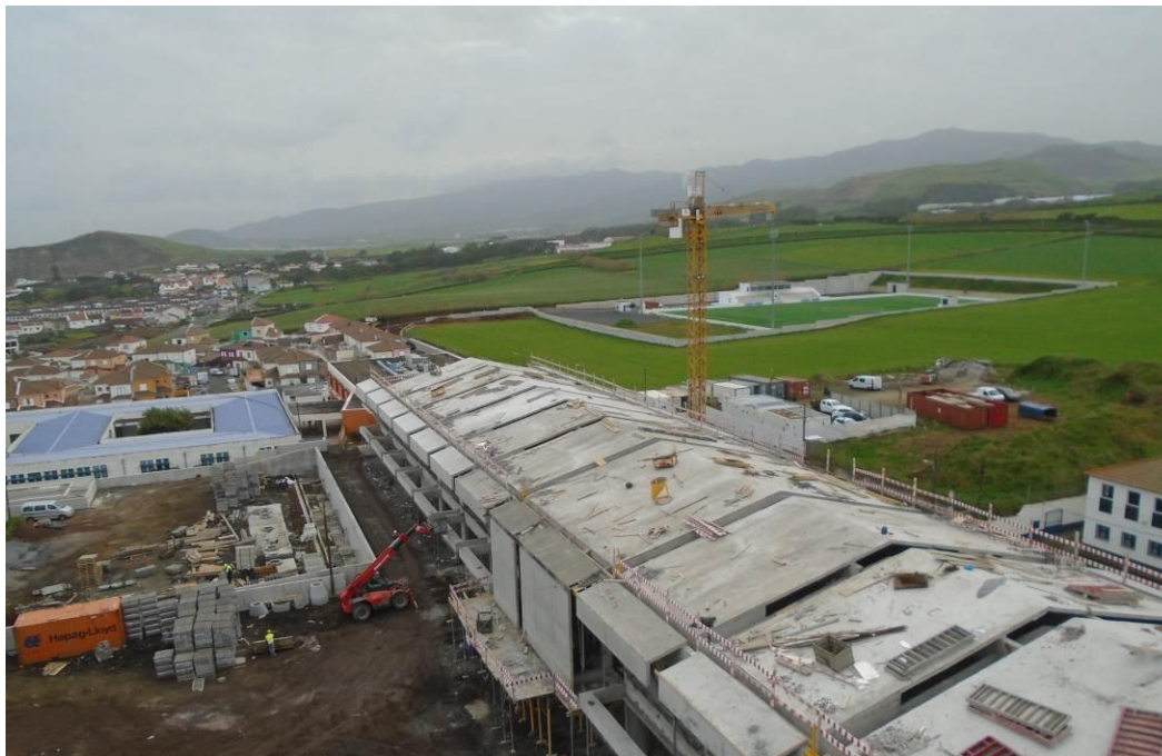
Fotografia 9 - Vista da Grua Torre (Alçado Nascente)
