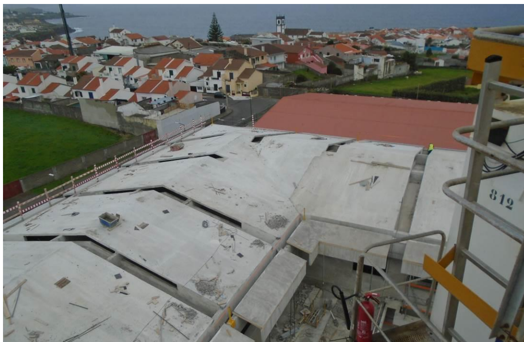
Fotografia 8 – Vista da Grua Torre (Alçado Poente)
