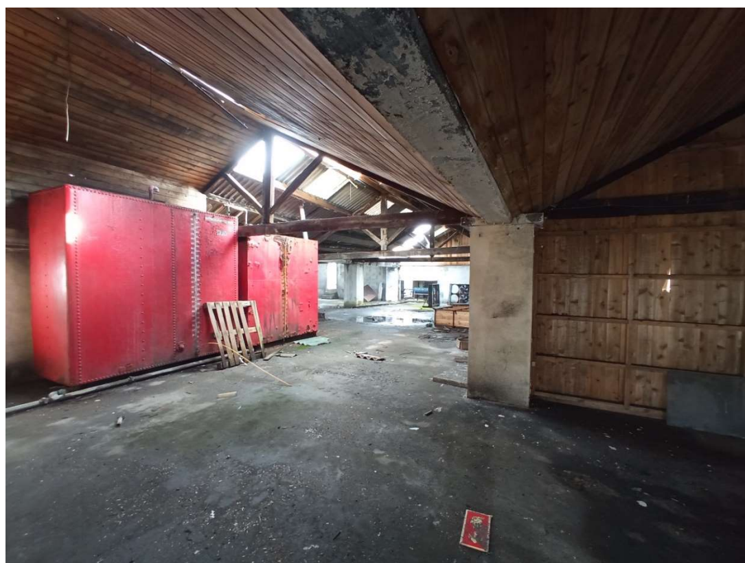
Fotografia 17 - Interior edifício das câmaras de frio (Piso 1)
