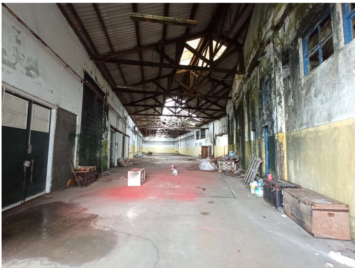
Fotografia 15 - Zona de circulação
