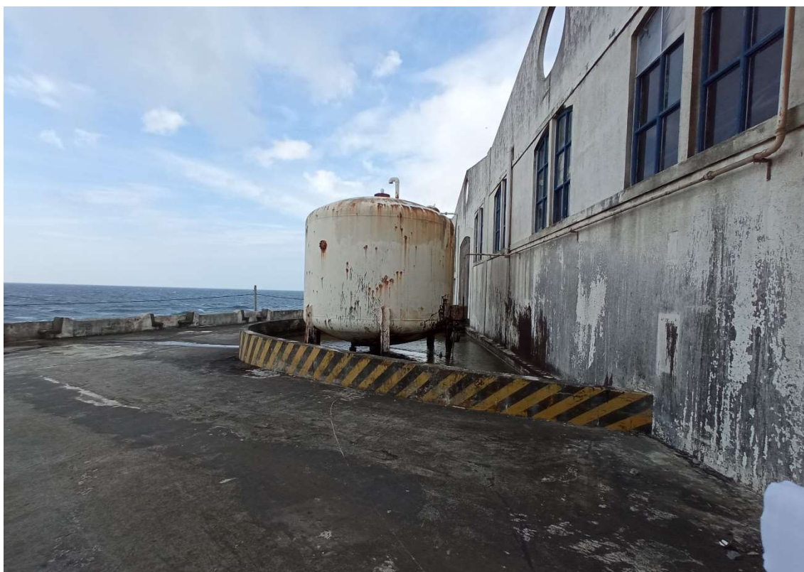
Fotografia 13 - Alçado sul (antigo depósito de nafta)
