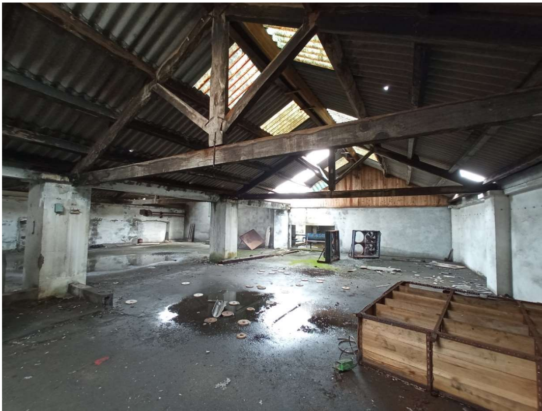
Fotografia 18 - Interior edifício das câmaras de frio (Piso 1)
