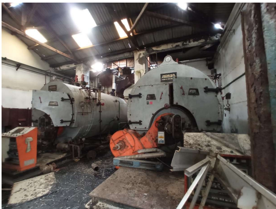
Fotografia 19 - Casa das caldeiras
