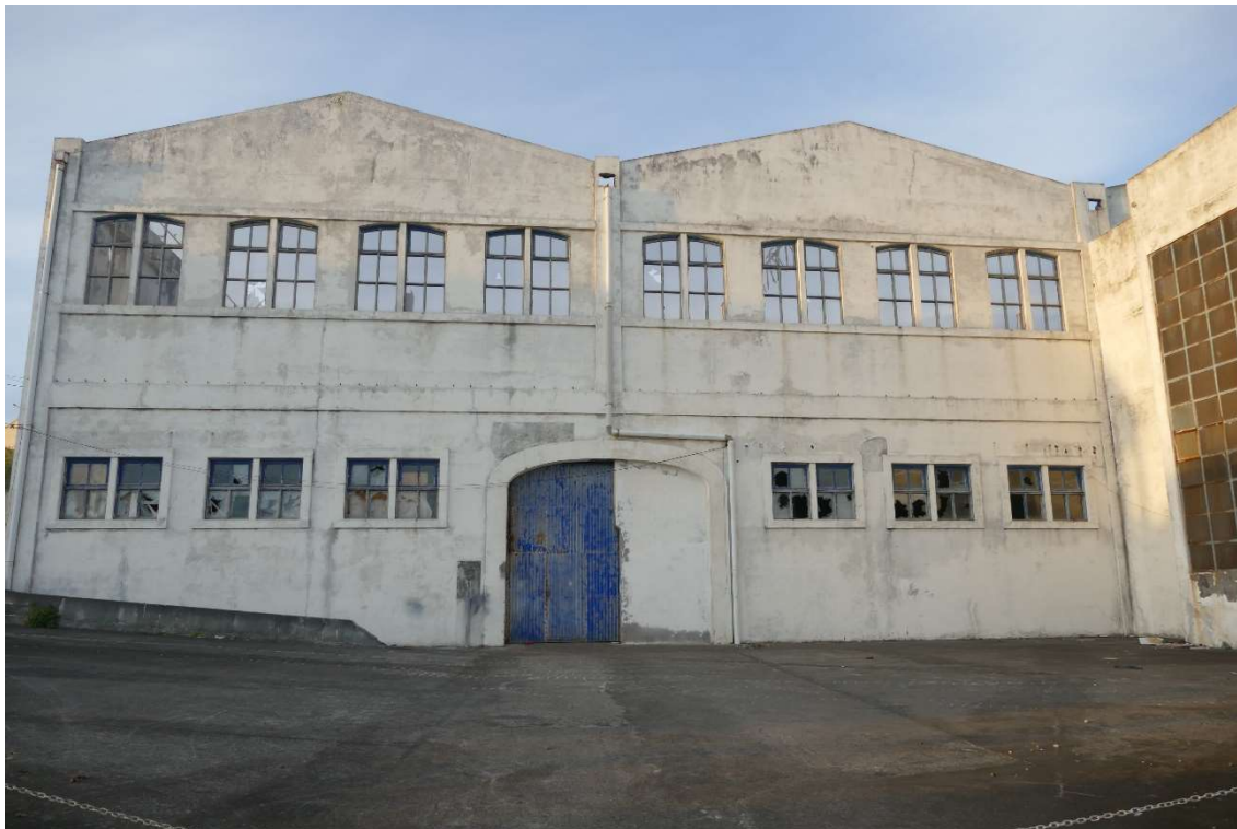
Fotografia 12 - Fachada sul do armazém resultante de ampliação (anos 80)
