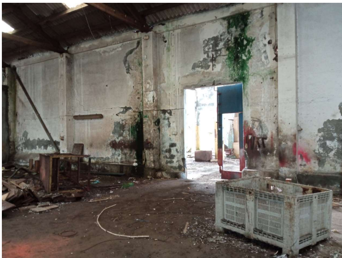
Fotografia 21 - Armazém de carpintaria/serralharia
