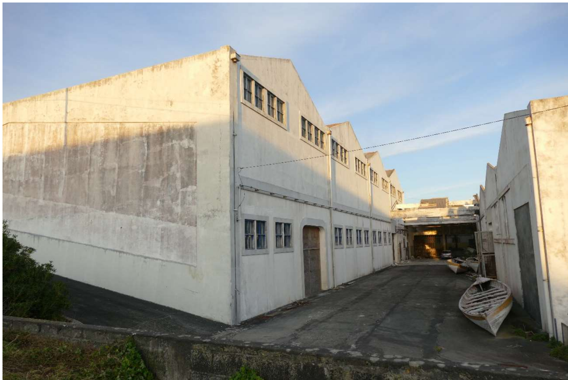
Fotografia 14 - Zona de circulação
