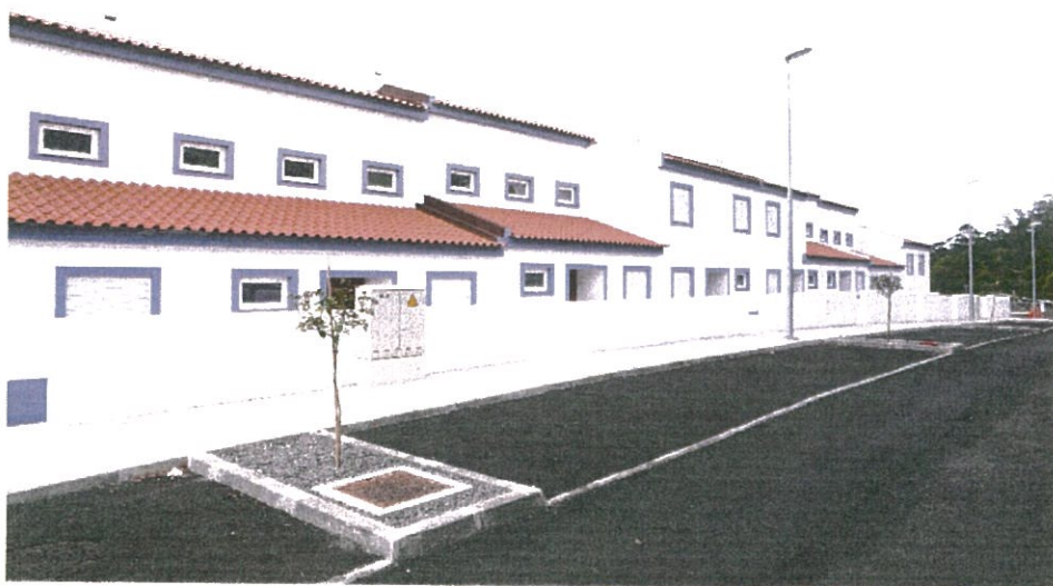
Foto/Imagem: Requalificação da Urbanização do Bairro da Terra Chã, Angra do Heroísmo
