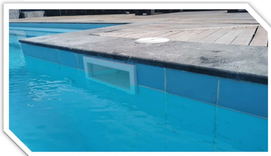
Imagem 6 - Reparação da piscina do Hotel da Graciosa
