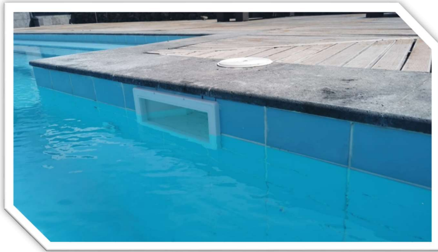
Imagem 6 - Reparação da piscina do Hotel da Graciosa
