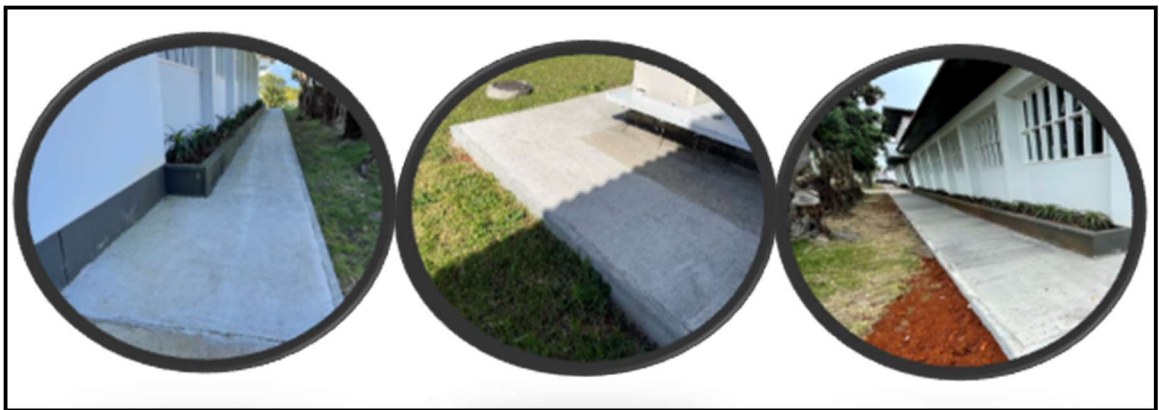
Imagem 1 - Alguns dos trabalhos realizados na Incuba + (Extensão pedonal)
