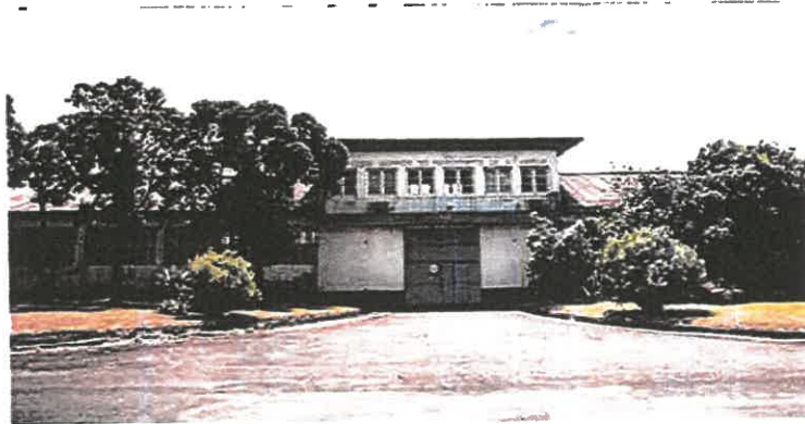
Ilustração 1. Fachada Antigas Oficinas Gerais do Aeroporto
