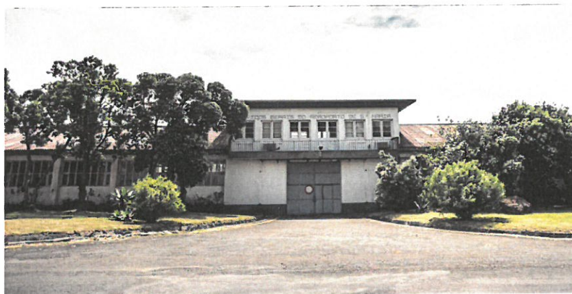
Ilustração 2. Fachada Antigas Oficinas Gerais do Aeroporto
