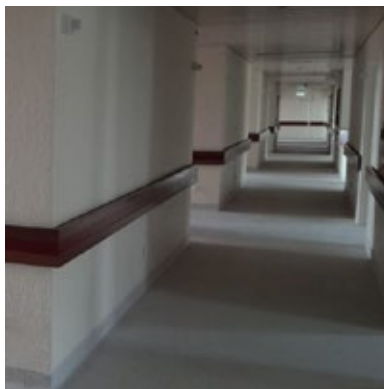
Obras Medicina IV
