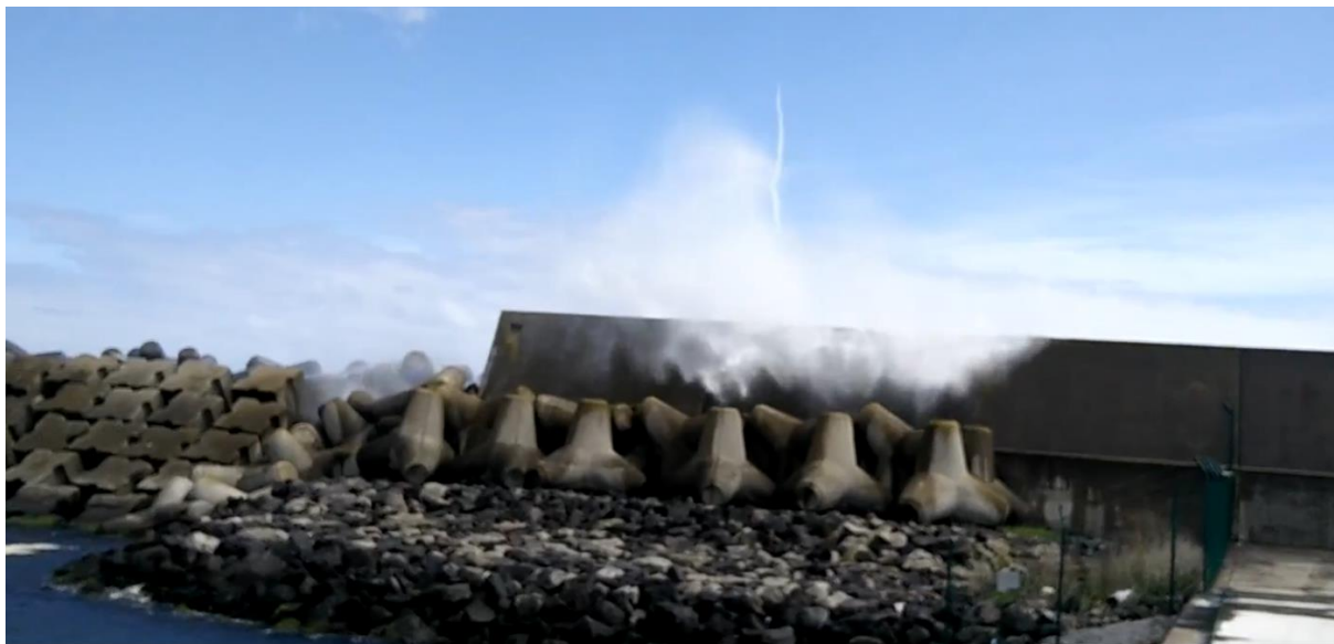
Figura 74 – Imagem do vídeo que mostra o galgamento do trecho final do muro-cortina
