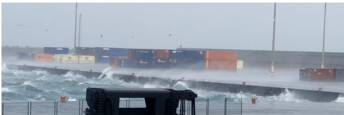
Figura 67 – Imagem retirada do vídeo que mostra os galgamentos do atual cais a (-12 m) ZH
