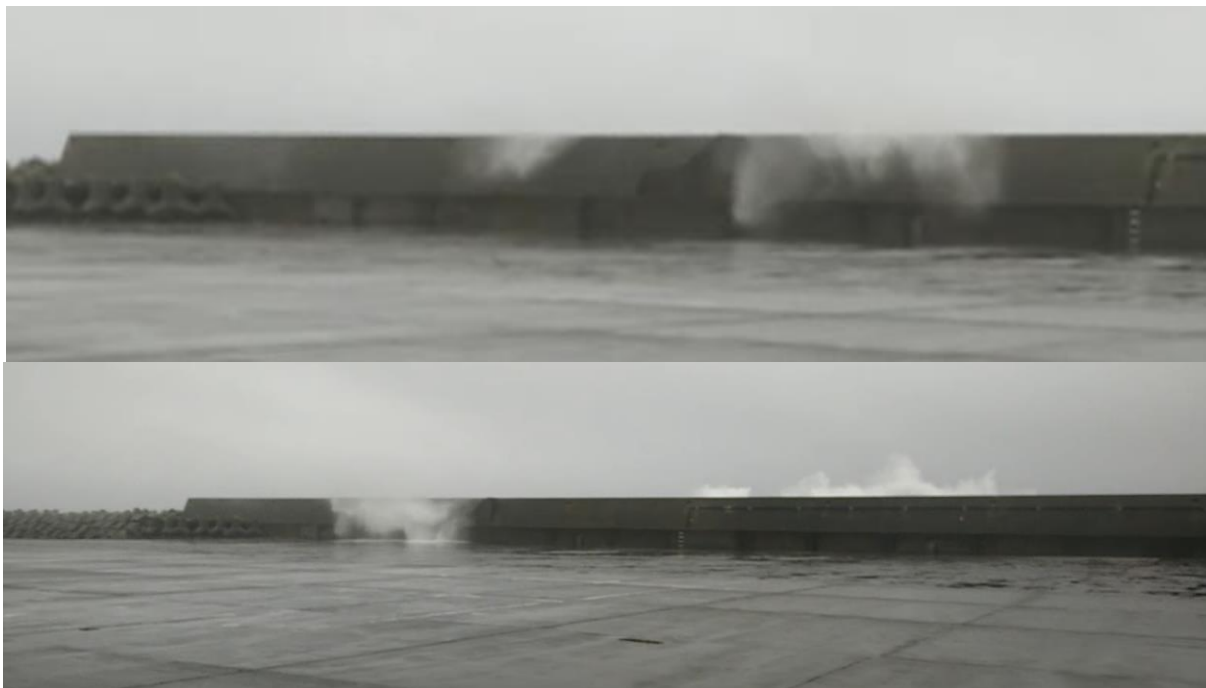
Figura 6 – Imagens do vídeo com o galgamento do molhe Sul (trecho com muro-cortina)
