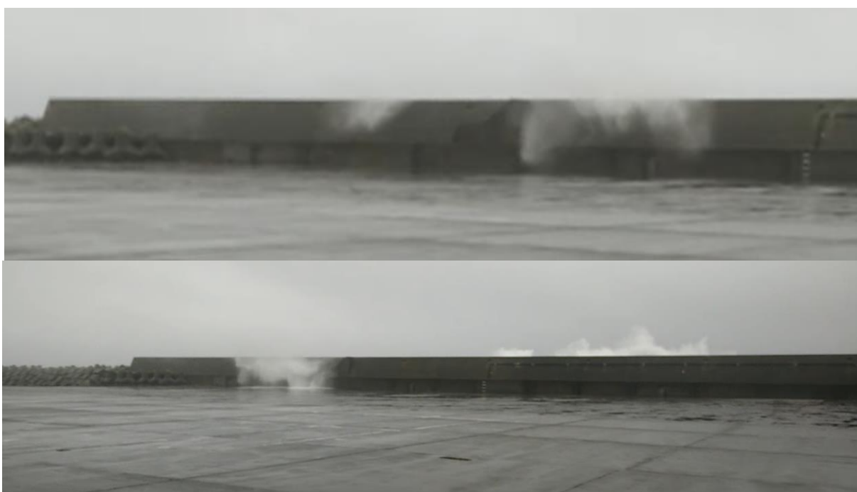
Figura 72 – Imagens do vídeo com o galgamento do molhe Sul (trecho com muro-cortina)
