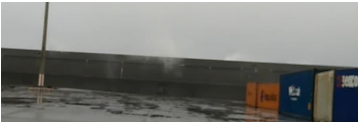
Figura 71 – Imagem do vídeo com o galgamento do molhe Sul (trecho com muro-cortina)
