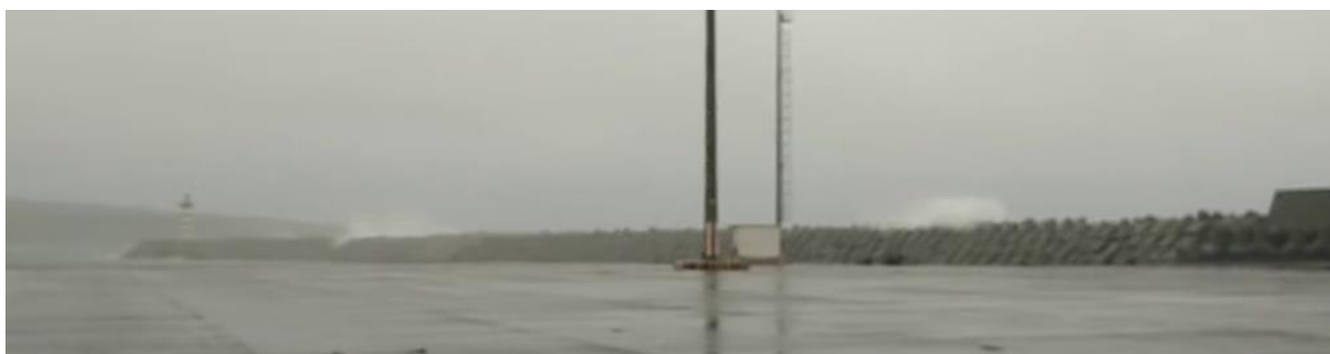
Figura 70 – Imagem do vídeo com o galgamento do molhe Sul (trecho sem muro-cortina)
