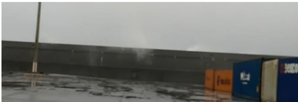
Figura 5 – Imagem do vídeo com o galgamento do molhe Sul (trecho com muro-cortina)
