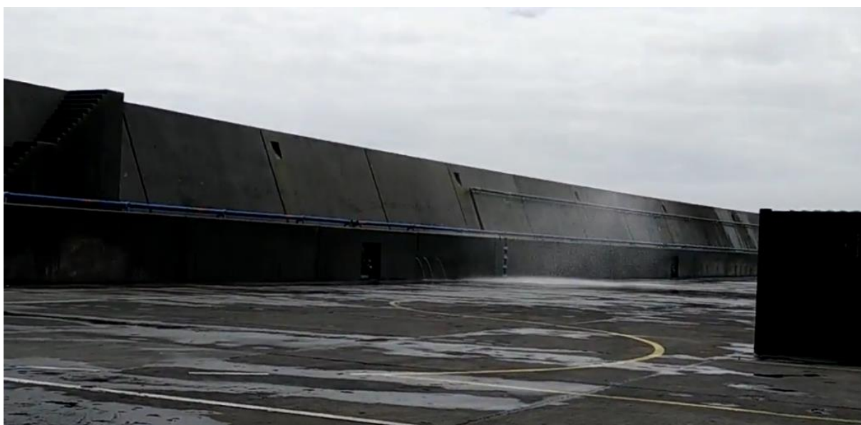
Figura 9 – Imagem do vídeo que mostra salpicos resultantes do galgamento do muro-cortina
