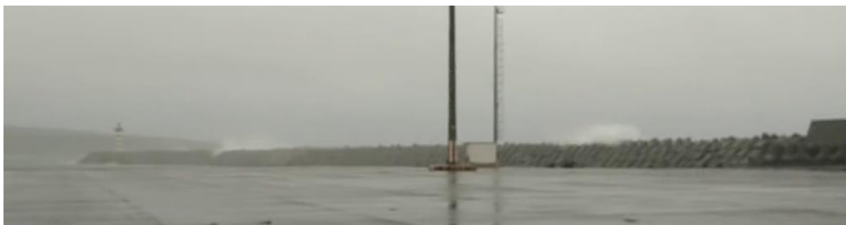
Figura 4 – Imagem do vídeo com o galgamento do molhe Sul (trecho sem muro-cortina)
